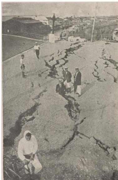
横浜厚木街道に於ける 大亀裂の光景 (『関東大震災画帖』文成社 1923年、国立国会図書館 デジタルコレクション)
