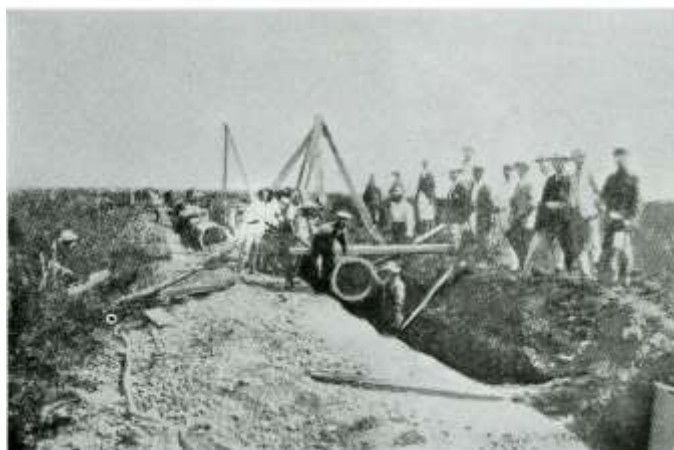
配水本管敷設工事のようす(『目で見える青森の歴史』より)
