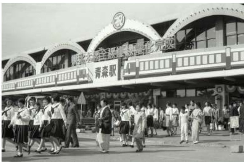
東北本線全線複線電化完成を祝う装飾が取り付けられた青森駅 (広報広聴課蔵)
