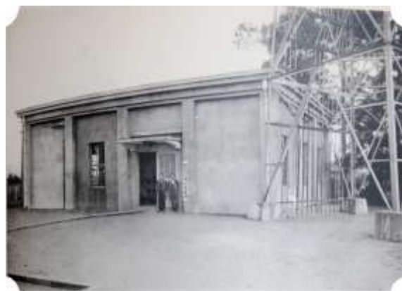
浪打変電所 (『青森電灯株式会社解散記念写真帳』より)
