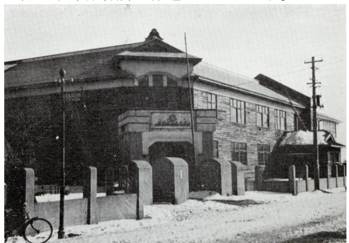
戦災で焼失した市立高等女学校の校舎を模して 同じ場所に再建された市立中央高等学校校舎 （昭和20年代後半、『復興した 新しい青森』より）
