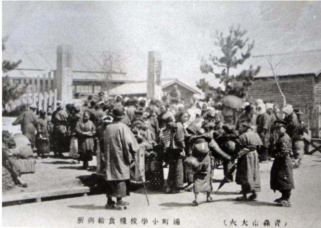
避難所となった浦町尋常小学校 (歴史資料室蔵)
