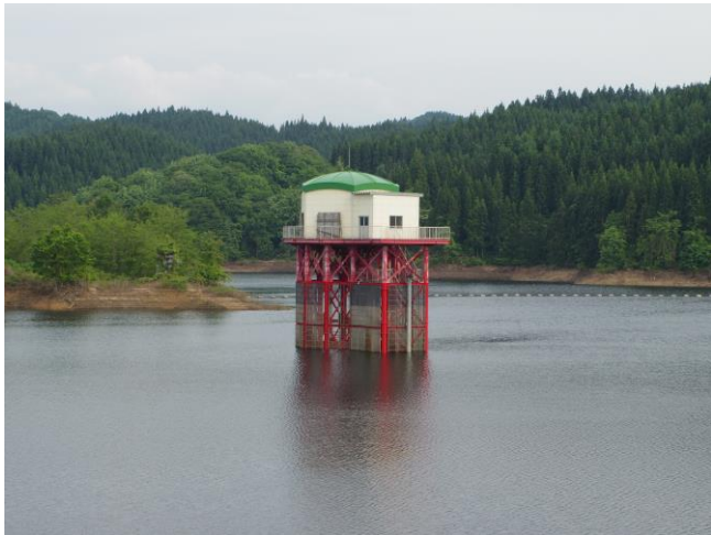
赤い取水塔 (ダムに水がある状態)
