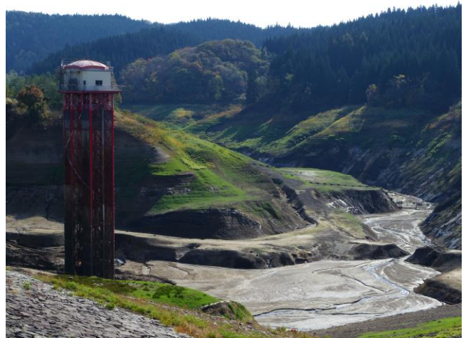
赤い取水塔 (工事のため水抜状態、2014年撮影)
