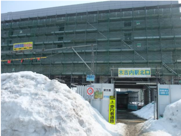
建設中の北海道新幹線木古内駅 (平成 26 年撮影)
