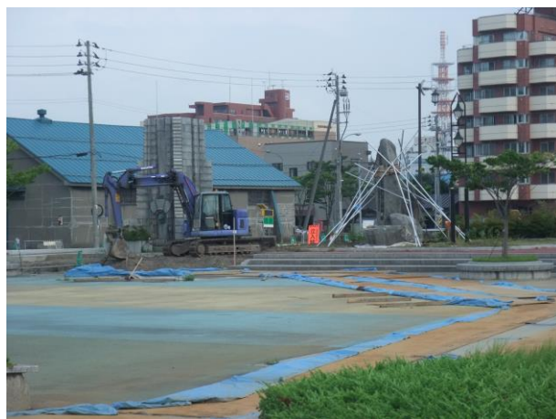
工事中の聖徳公園 (平成 24 年撮影)
