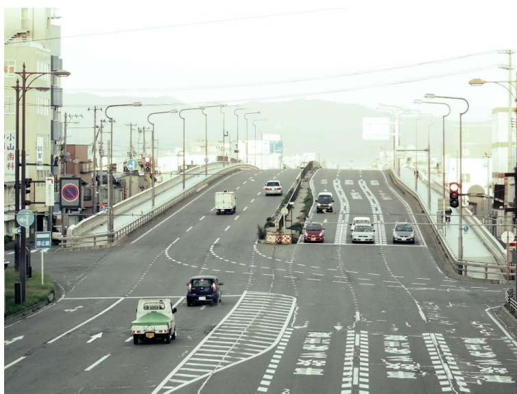
古川歩道橋からみた現在の古川跨線橋
