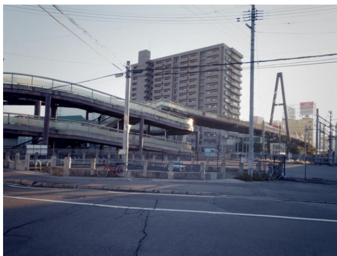
青森駅西口付近からみたあすなろ橋
