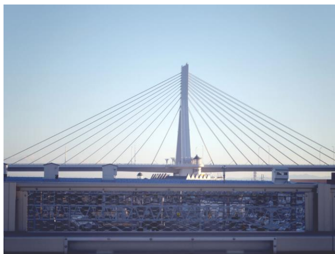
あすなろ橋からみた青森ベイブリッジ
