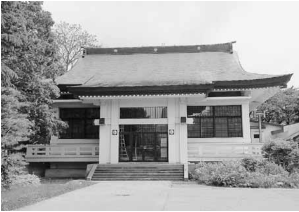
【写真③】仮の「藩庁」となった蓮心寺
