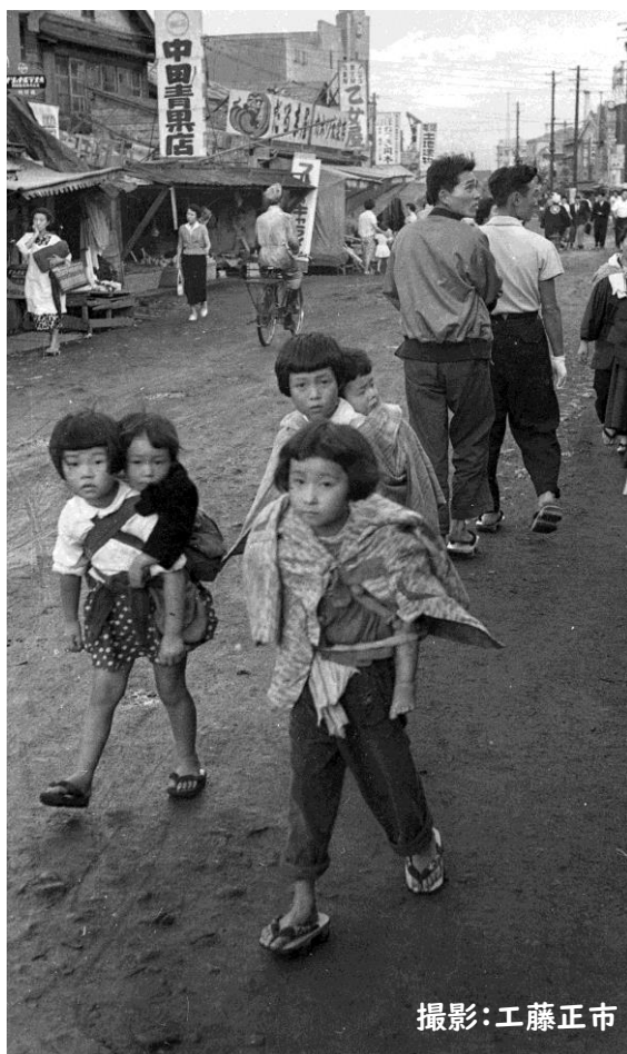
ニコニコ通りで撮影された写真 (撮影：工藤正市 提供：工藤加奈子)
